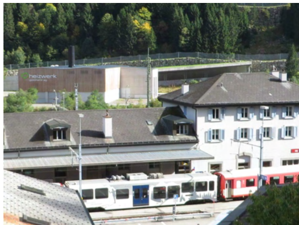
Bahnhofgebäude Göschenen mit Gleisen der MGB und dem Holzheizwerk der Gotthard AG.
