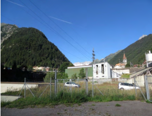
Talstation der militärischen Luftseilbahn Göschenen – Gütsch.
