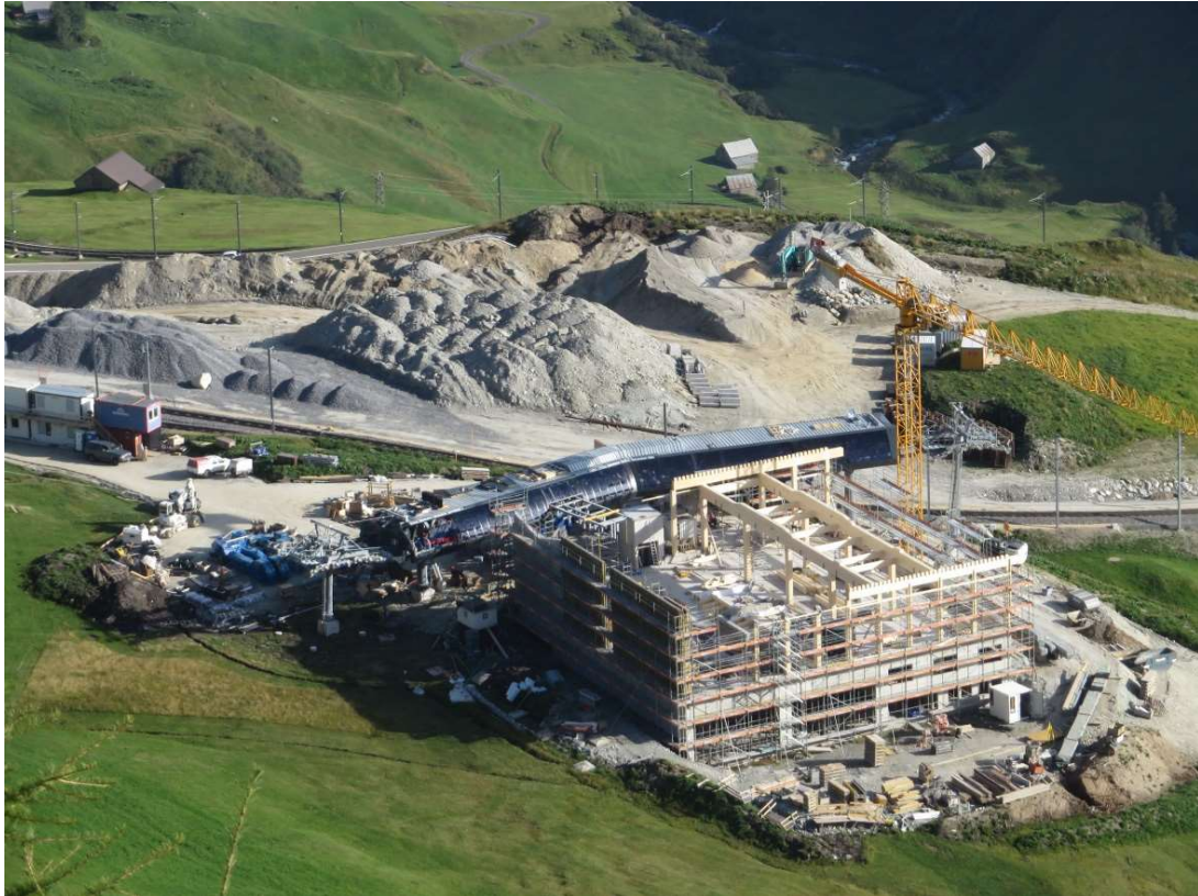
Grossbaustelle im August 2017 für Eisenbahn, Gondelbahn und Restaurant am Nätschen.
