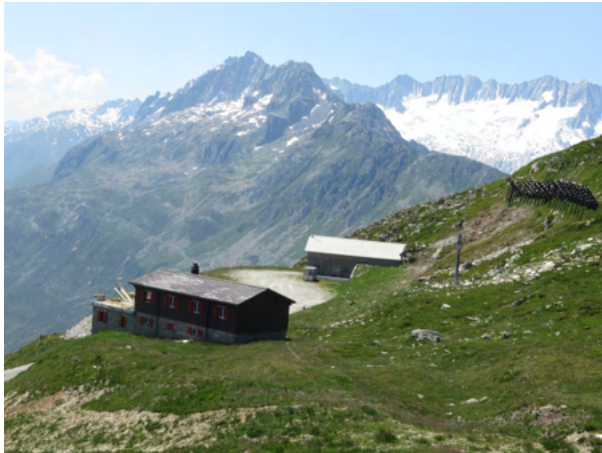
Wetterstation und südlicher Festungseingang Gütsch.
