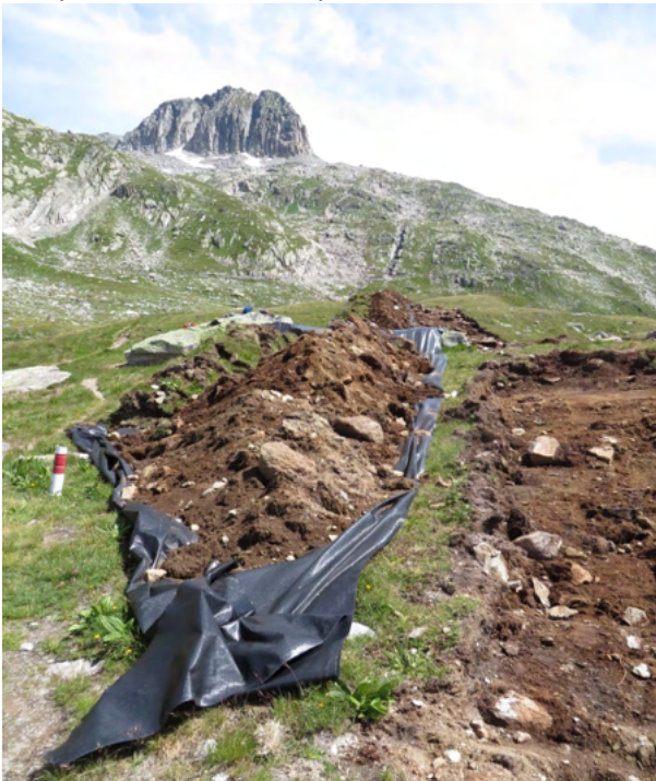
Die Leitungen beim Lutersee wurden nach der Bauphase wieder humusiert.
