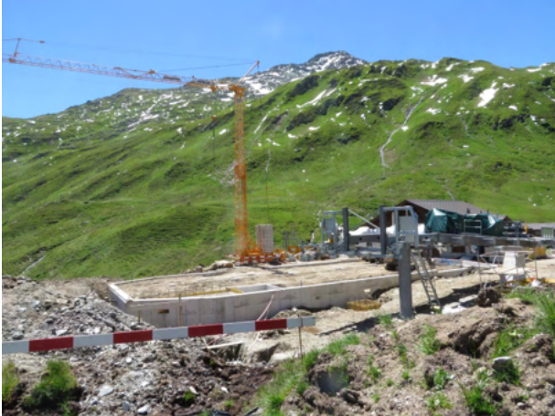
Baustelle für die Talstation der Gondelbahn Schneehüenerstock-Express.
