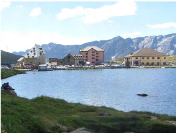
Das Nationale Gotthardmuseum befindet sich im Gebäude rechts im Bild.
