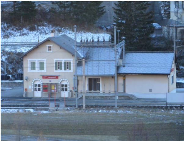
Der Bahnhof von Hospental steht unter Heimatschutz.
