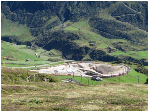
Bauarbeiten zur Umgestaltung des Bahnhofs Nätschen.
