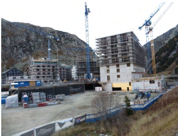
Baustelle Andermatt Reuss am 31.10.2016.
