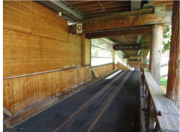
Die Bobschlitten rollen auf Schienen den „Hang“ hinunter und pendeln wieder zurück.
