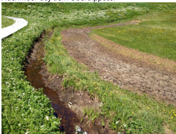
Entwässerungsgraben zwischen Oberem und Unterem Bäs. (Foto Martin Käch, 2015)
