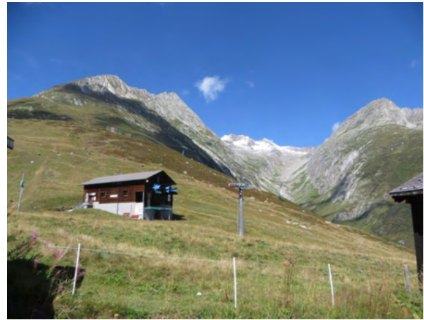
Bergstation des Milez-Flyers, Sesselbahn von Dieni nach Milez.
