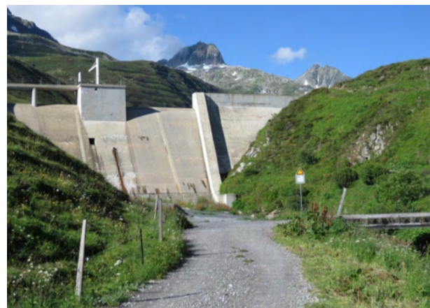
Mit der Stauanlage in der „Schöni“ kann die Wassermenge reguliert werden.
