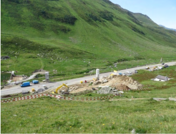
Bau der Pumpstation an der Oberalpstrasse.
