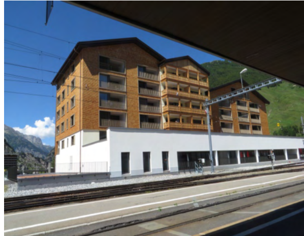
Auf der Nordseite des Bahnhofs Andermatt entstand ein neuer Gebäudekomplex.
