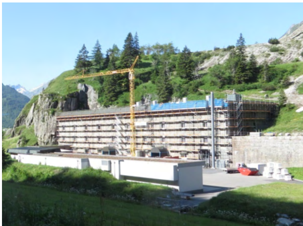
Die sogenannte Kriegskaserne Bühl in Andermatt aus dem Jahr 1888, Renovation 2021.
