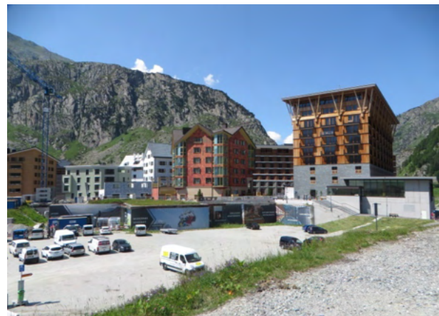
Neben dem bestehenden Gebäudekomplex wird das Podium für neue Bauten erweitert.
