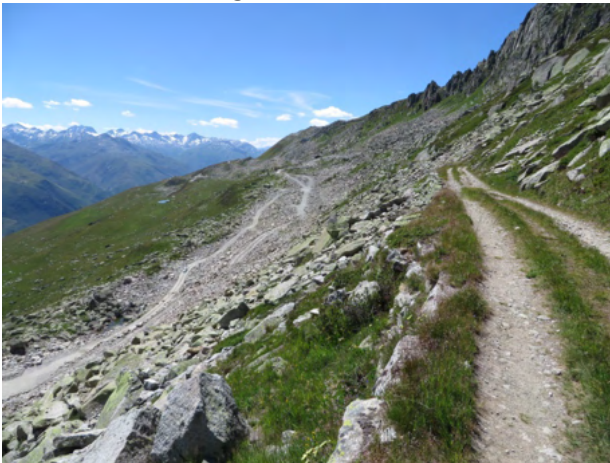
In der Strahlgand wurden vor dem Bau der Pisten grosse Steine abgebaut. Foto am 3. August 2015.
