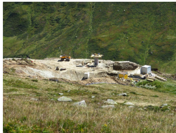
Bau der neuen Liftanlage Unterstafel auf dem Grossboden.
