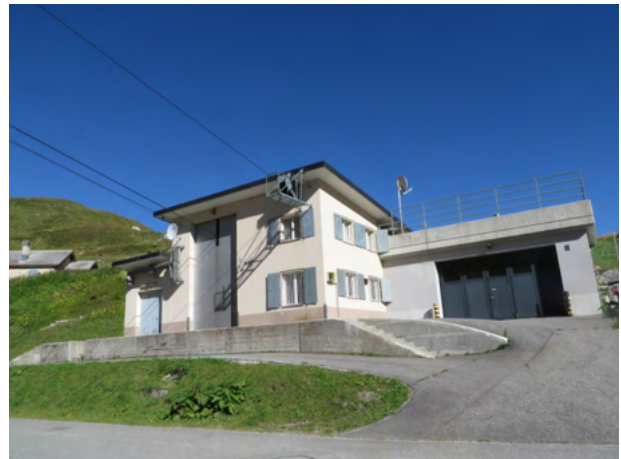
Talstation der militärischen Seilbahn zum Schneehüenerstock vor dem Bau des Express.
