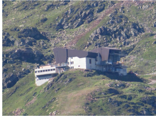
Die Zwischenstation Gurschenalp mit den beiden Seilbahnsektionen der Gemsstockbahn.
