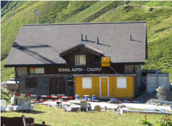
Talstation des alten Skilifts (Runal Alpsu – Calmut) auf dem Oberalppass am 23. August 2016.
