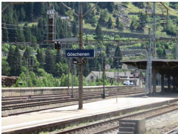
SBB-Bahnhof Göschenen mit der still gelegten Rampe für den Autoverlad durch den Gotthard.
