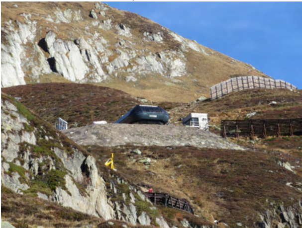
Landschaftseingriffe für das Erstellen der Talstation Vorder Felli – Schneehüenerstock.
