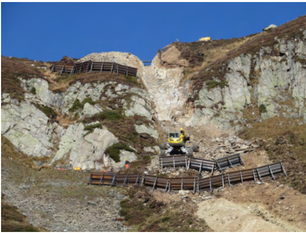
Schneise für die Leitungen oberhalb des neuen Pumpwerks beim Oberalpsee.
