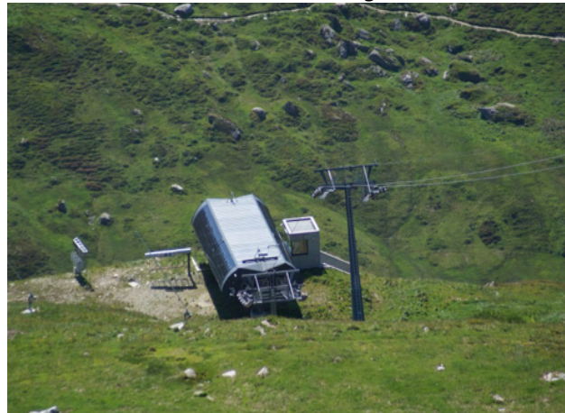
Talstation der heutigen 6er-Sesselbahn Unterstafel – Gütsch (Gütsch-Flyer).
