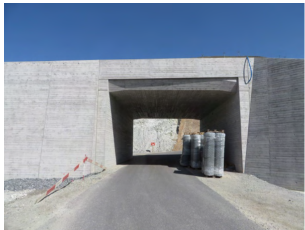
Unterführung beim Bahnhof Nättschen am 29. August 2017.
