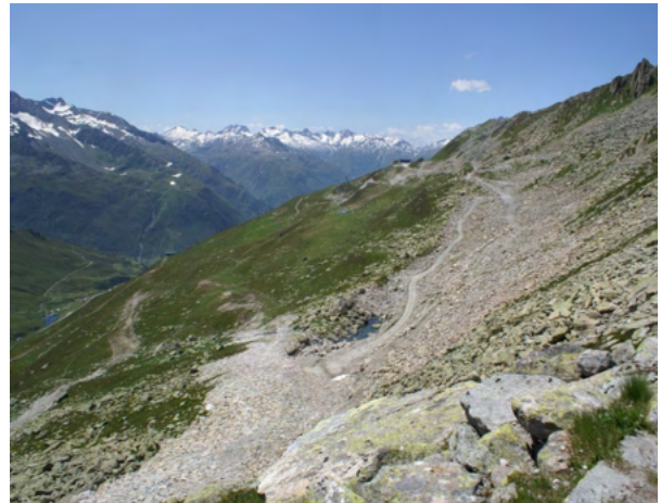
Gütsch und Strahlgand nach dem Bau der Pisten am 20. Juli 2021.
