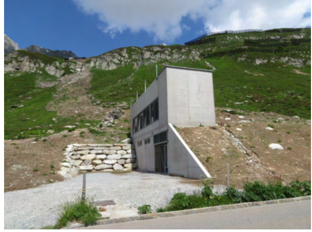
Pumpstation für die Beschneigungsanlagen beim Oberalpsee.
