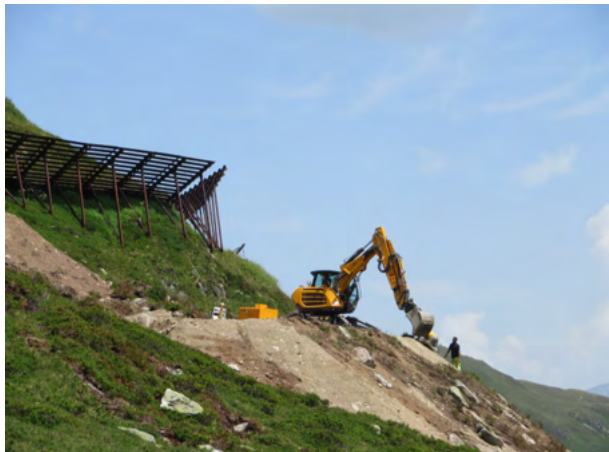
Baustelle zwischen Lawinerverbauungen in der Vorder Felli.
