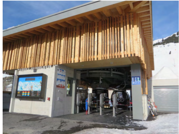
Talstation der neuen Achtergondelbahn Gütsch-Express 1. Sektion in Andermatt.
