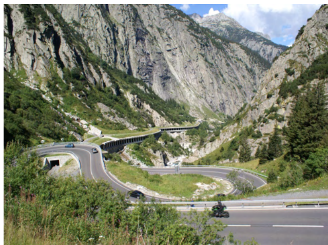
Ausgebaute Schöllenenstrasse Göschenen – Andermatt.
