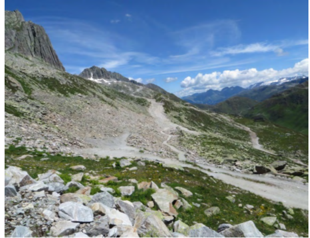
Strahlgand nach dem Bau der Pisten am 19. Juli 2020.
