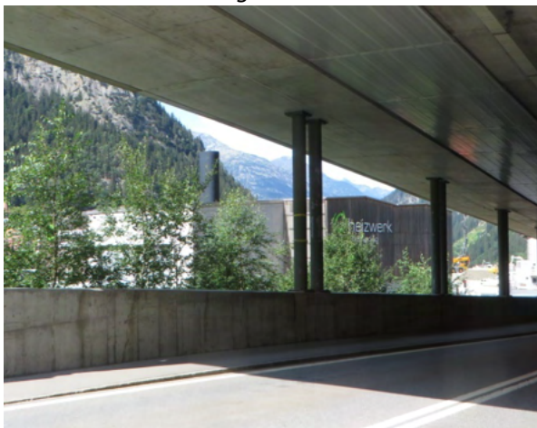
Holzheizwerk der Gotthard AG für die Erzeugung von Fernwärme in Göschenen.
