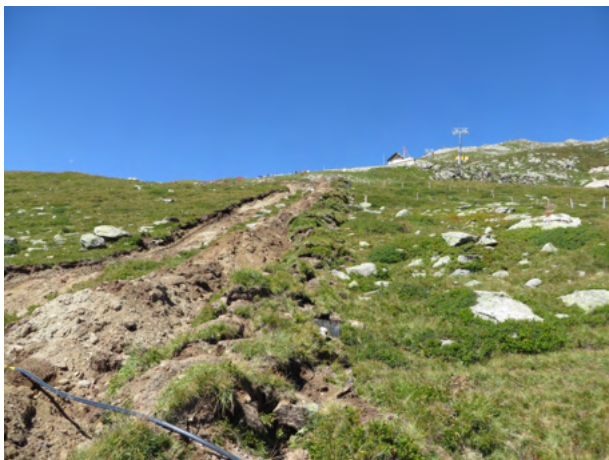
Bau der Wasserleitung für die Beschneigungsanlage der Piste Unterstafel – Gütsch.
