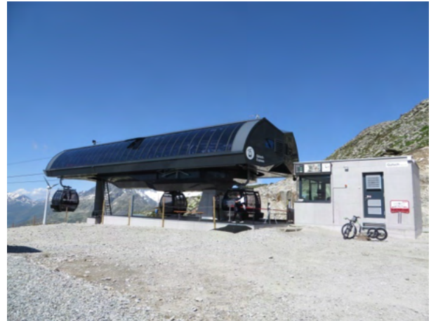
Bergstation der Gondelbahn Gütsch-Express auf einer Höhe von 2367 m ü. M.
