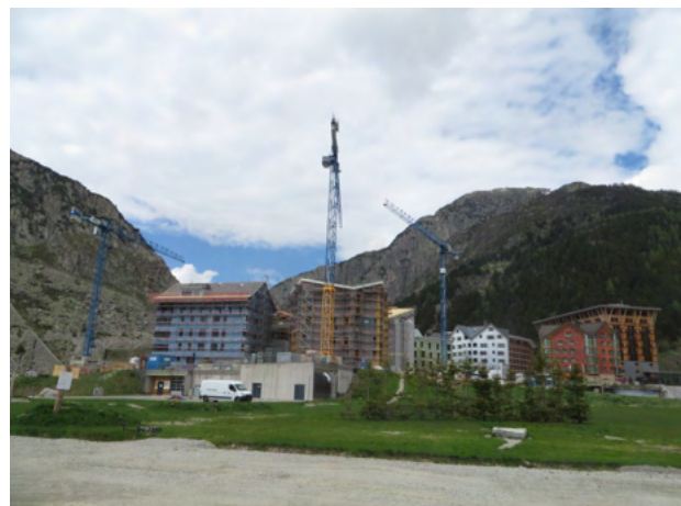
Baustelle Andermatt Reuss am 3.06.2021.
