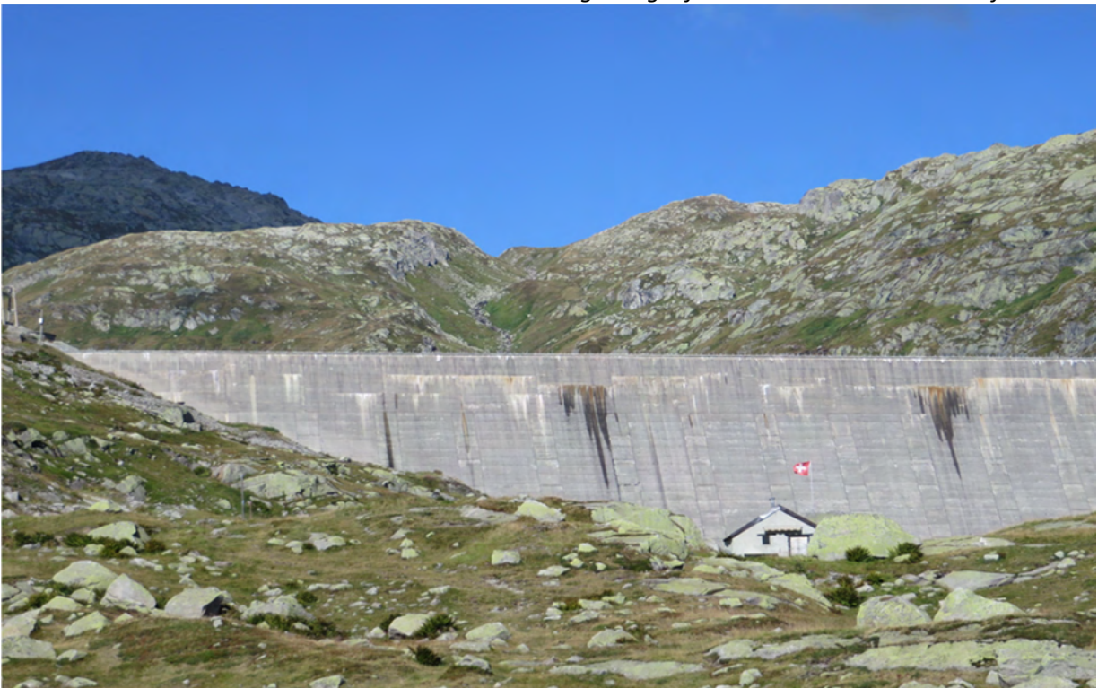
Staumauer des Lucendro-Stausees. Das Urner Wasser fliesst in den Kanton Tessin. Im Jahr 2025 läuft die bestehende Wassernutzungskonzession aus. Sie soll neu vergeben werden. Mit mehr Restwasser?
