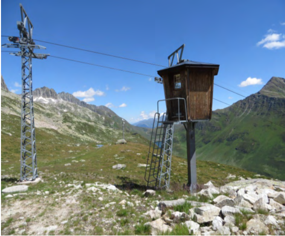
Bergstation des ehemaligen Skilifts vom Grossboden zum Gütsch.
