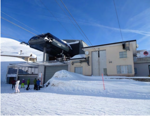
Neue Talstation des Schneehüenerstock-Express auf dem Oberalpass.
