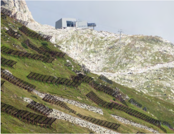
Lawinverbauungen in der Vorder Felli zwischen Nätchen und Oberalppass.
