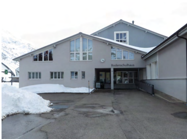
Das Bodenschulhaus in Andermatt wird zurzeit umfassend renoviert.
