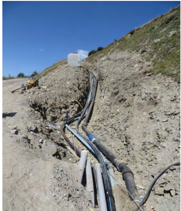
Leitungen für Strom, Trinkwasser und Beschneigungsanlagen am Gütsch werden verlegt.
