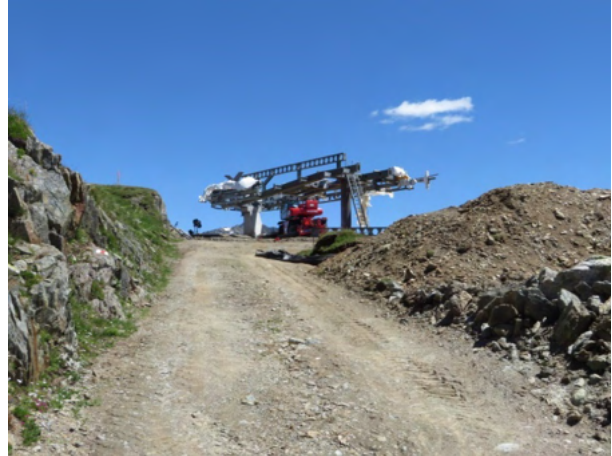
Errichten der neuen Bergstation des Oberalp-Flyers auf dem Piz Calmot.
