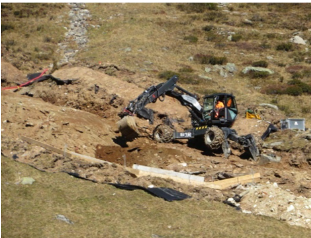
Ein Schreitbagger verlegt Leitungen für Wasser und elektrischen Strom.
