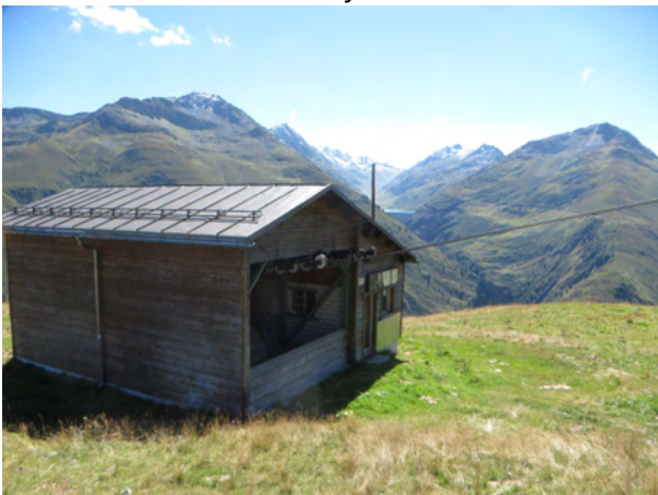
Talstation des Skilifts Tegia Gronda.
