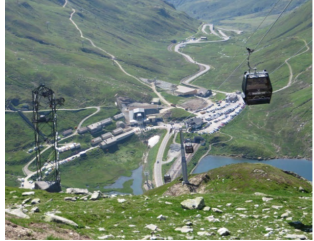
Oberalpass mit Militärseilbahn (links) und Gondelbahn von Platte aus gesehen.
